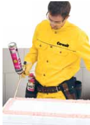
Klejenie płyt styropianowych w złożonych systemach ocieple- niowych Ceresit Ceretherm
