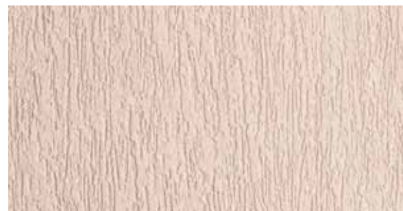
Tynk mineralny o fakturze „kornikowej” Ceresit CT 35 , o uziarnieniu 2,5 mm, otrzymywany przez zacieranie pacą w jednym kierunku.
