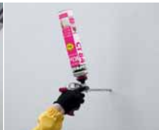
Uzupełnianie kleju w przypadku klawiszowania płyt
