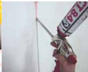
Uzupełnianie szczelin pomiędzy płytami styropianowymi
