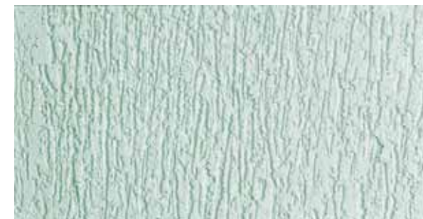
Tynk mineralny o fakturze „kornikowej” Ceresit CT 35 , o uziarnieniu 3,5 mm, otrzymywany przez zacieranie pacą w jednym kierunku.
