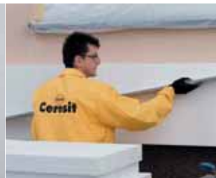
Przyklejanie płyt styropianowych w przypadku „ocieplenia na ocie- plenie”
